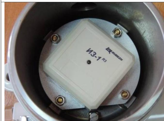
Рисунок Г.2 – Вид коробки сверху со снятой крышкой
